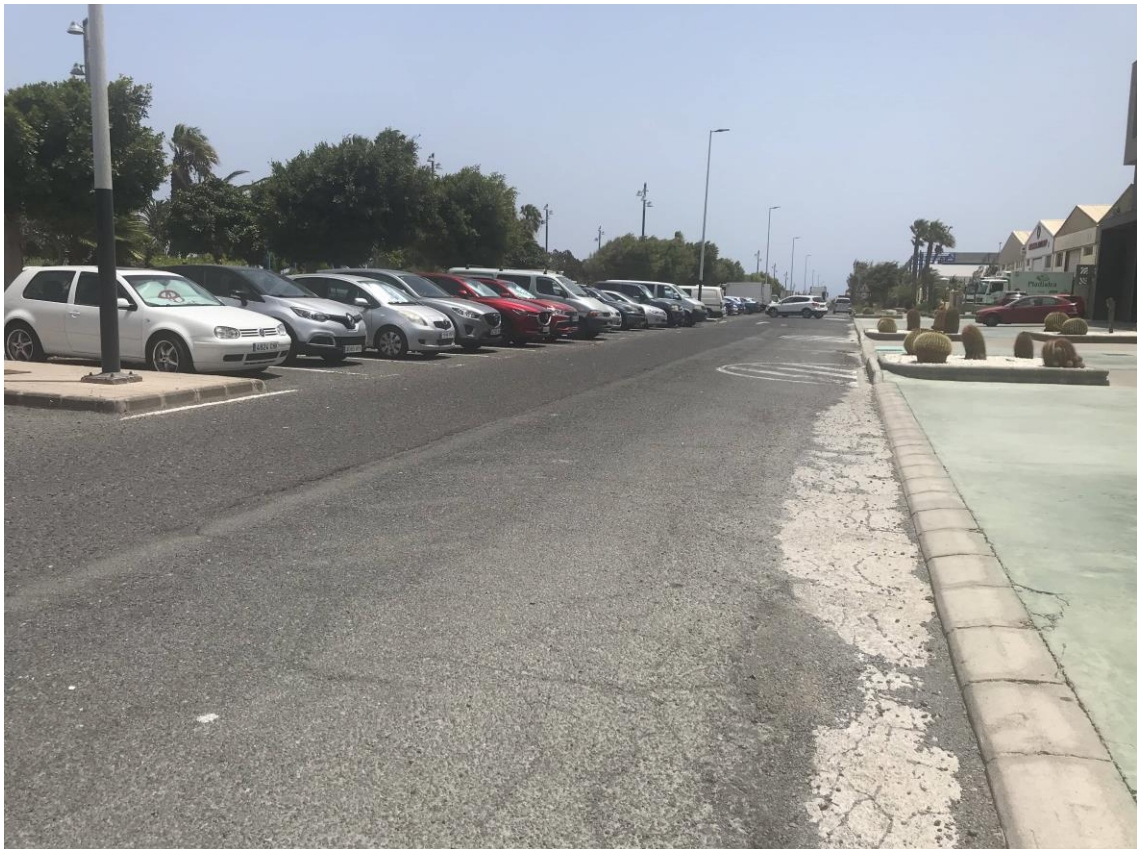
Imagen 12. Vista general del estado actual.
