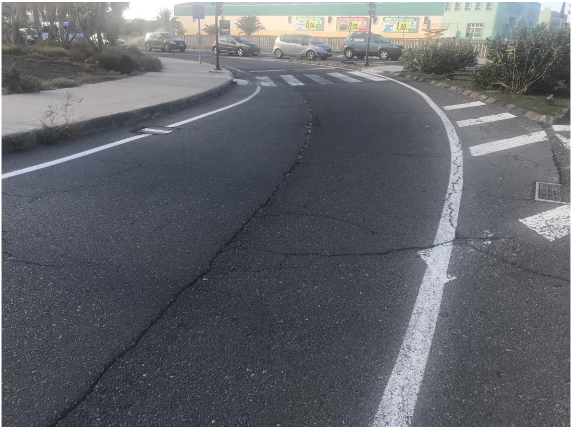
Imagen 10. Tramo 2. Enlace de Canal Izquierda a salida hacia GC-191.
