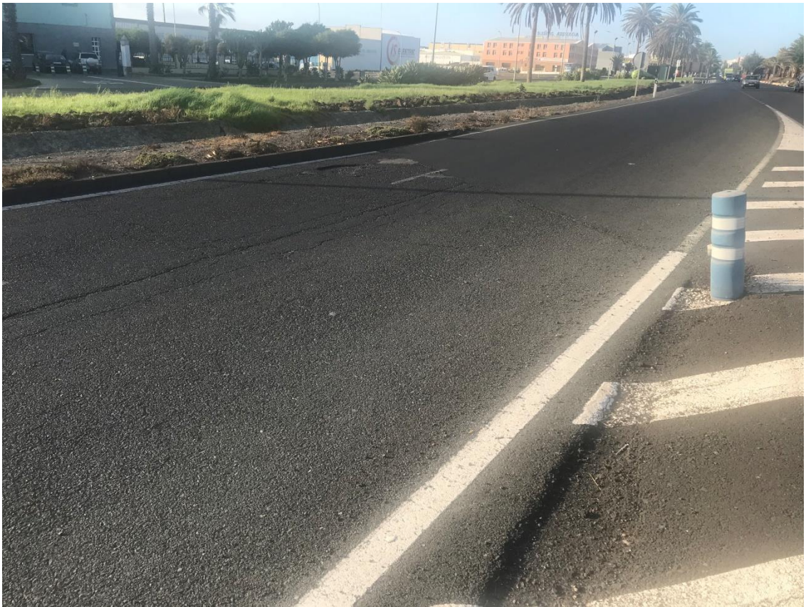
Imagen 04. Junta de unión de tramo 1 con GC-191.
