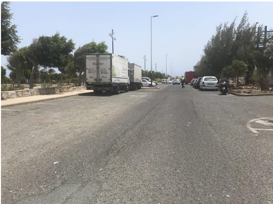
Imagen 13. Vista general del estado actual.
