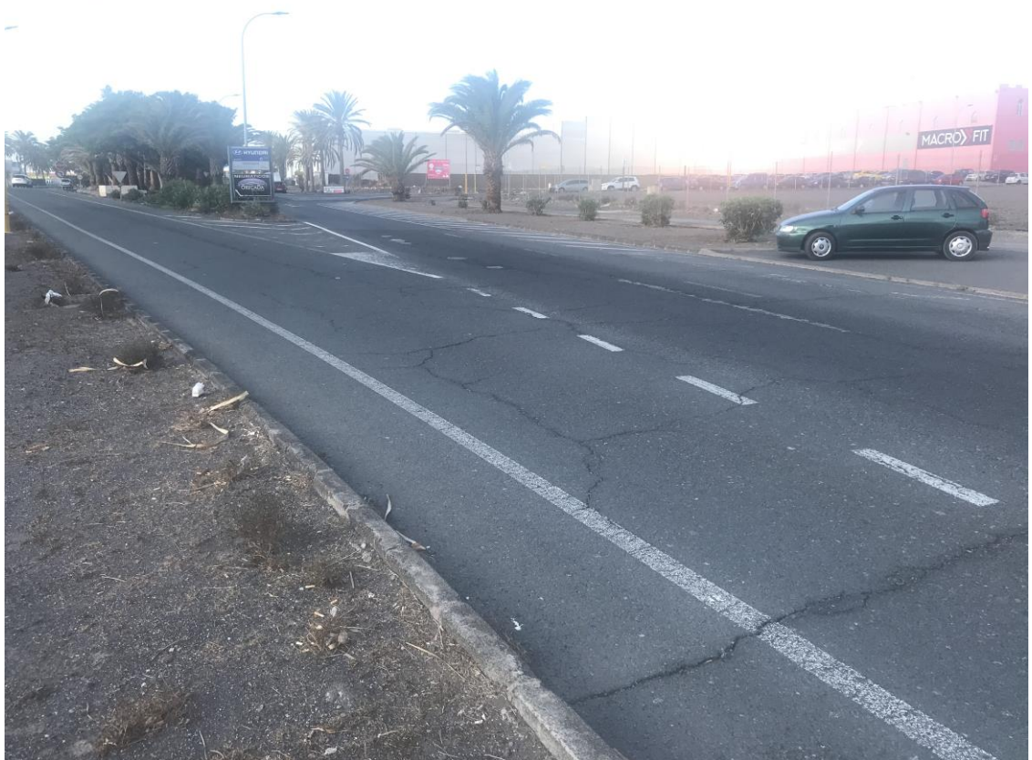
Imagen 05. Junta de unión y bifurcación de tramo 4 hacia GC-191.
