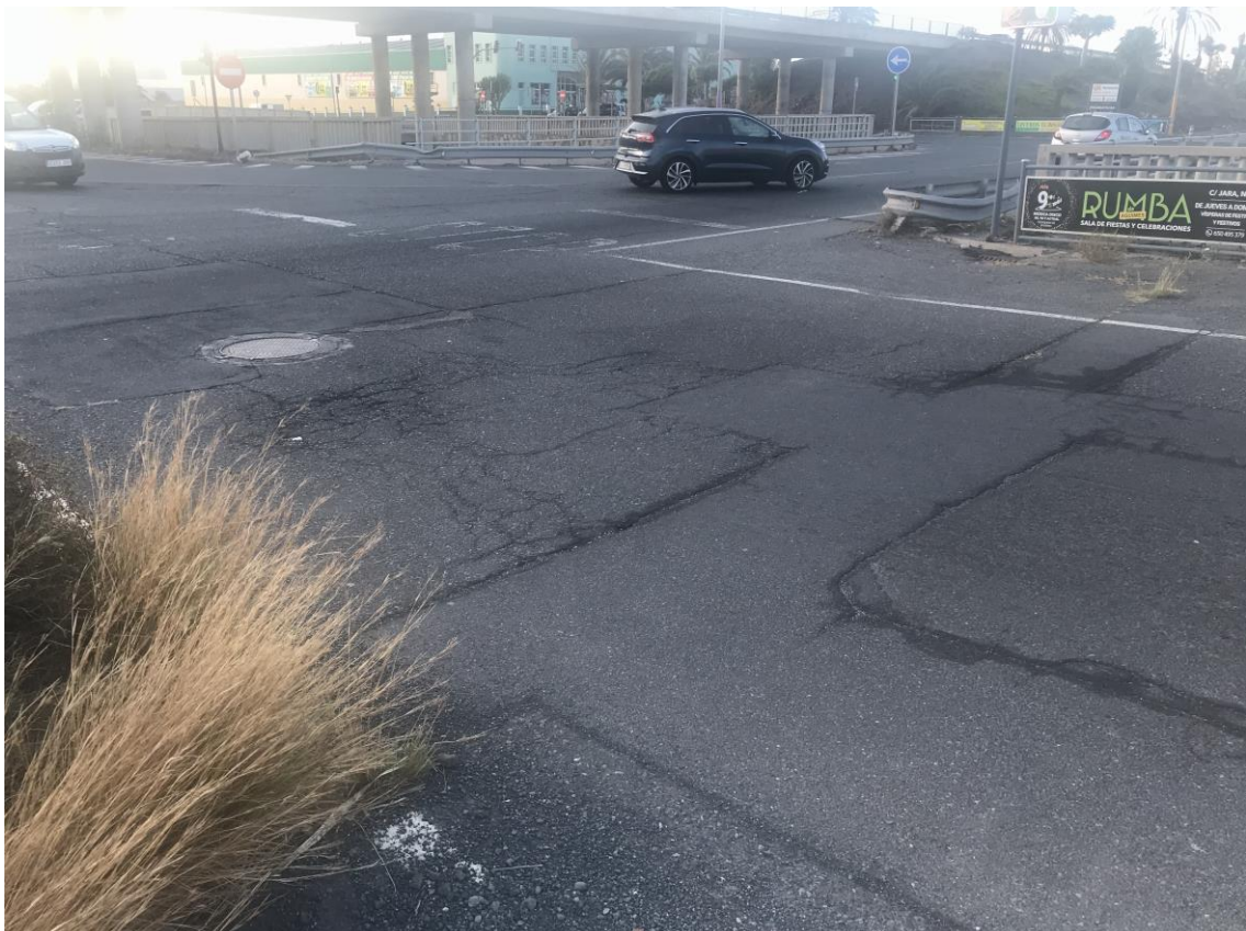
Imagen 07. Vista de tramo 5 e inicio de desvío provisional.
