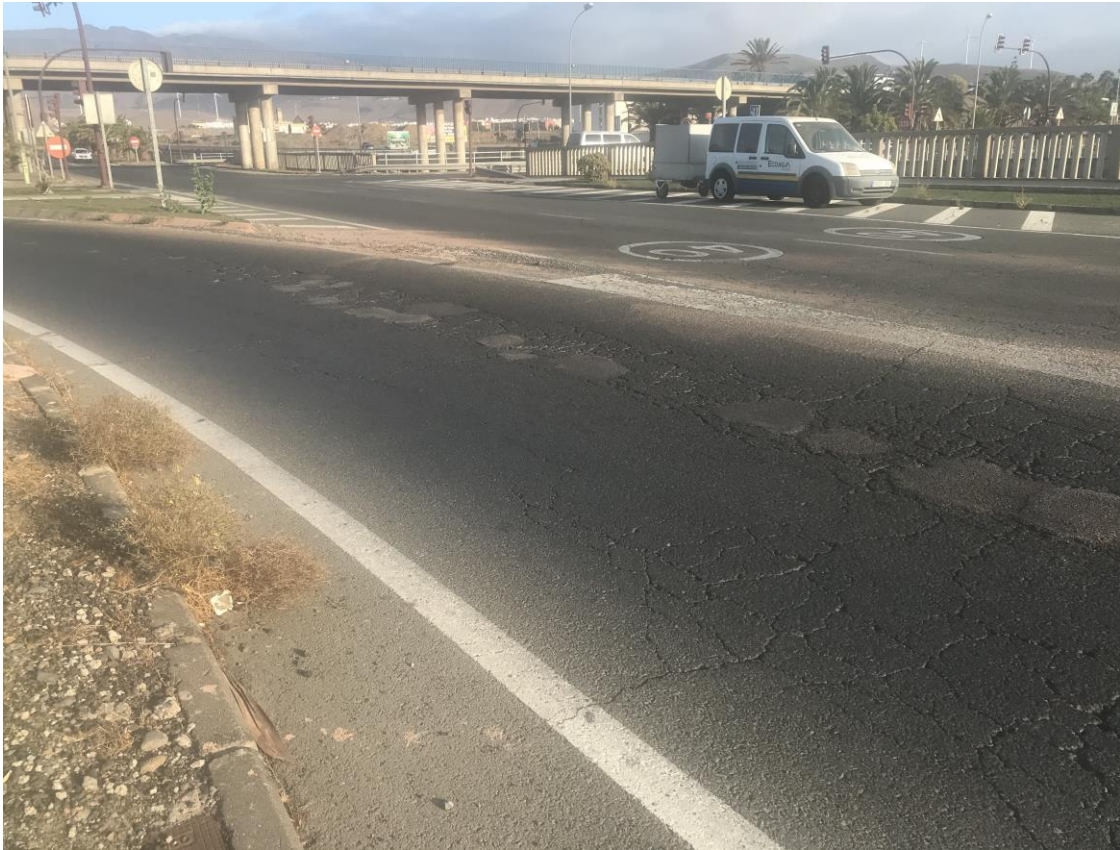
Imagen 02. Vista tramo 1 y tramo 5.
